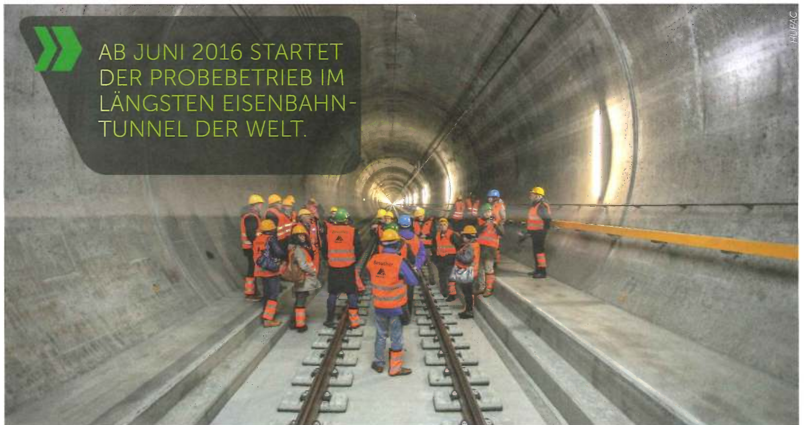
Der Gotthard-Tunnel nimmt immer konkretere Gestalt an
