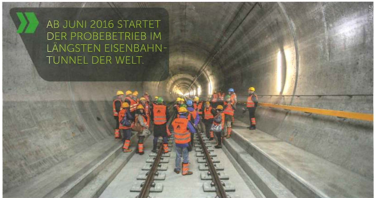
Der Gotthard-Tunnel nimmt immer konkretere Gestalt an
