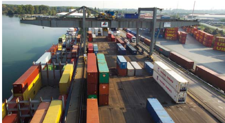
Terminal intérieur trimodal de Germersheim (route, rail, navigation intérieure)
