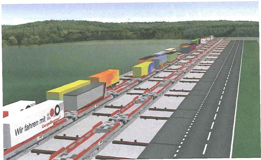
Über die Balken quer zum Gleis werden die Waggonaufsätze verschoben.
