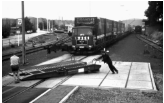
Rollende Landstraße 1984: Umschlaganlage Mainz-Gustavsburg – ein eingepflastertes Gleis mit Auffahrrampe
